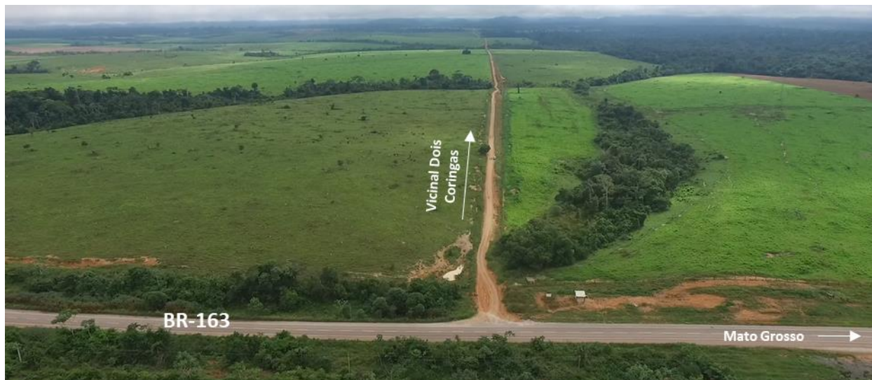
Figura 1.4-8 - Trecho Pavimentado da BR-163 na interseção com a Vicinal Dois Coringas.
