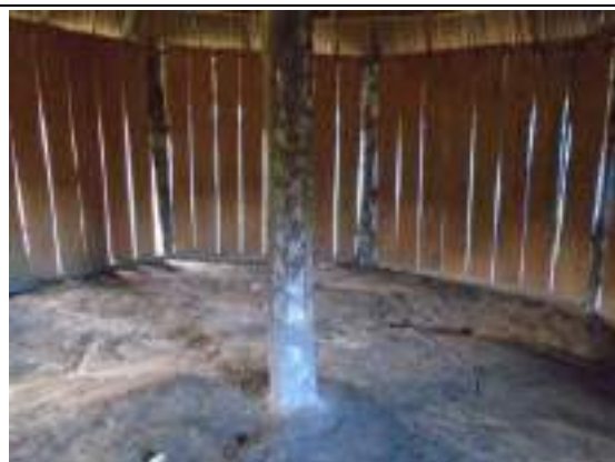
Foto 39: Esteio de acapu ( Vouacapoua americana ) existente na Casa da Cultura do Índio da aldeia Furo Seco (25/4/19).
