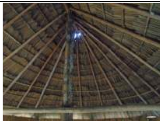
Foto 40: Detalhe de cobertura da Casa da Cultura do Índio da aldeia Furo Seco (25/4/19), feita com madeiras de ar como amejú ( Duguetia flagellaris ) e cobertura de palha de inajá ( Attalea maripa ).
