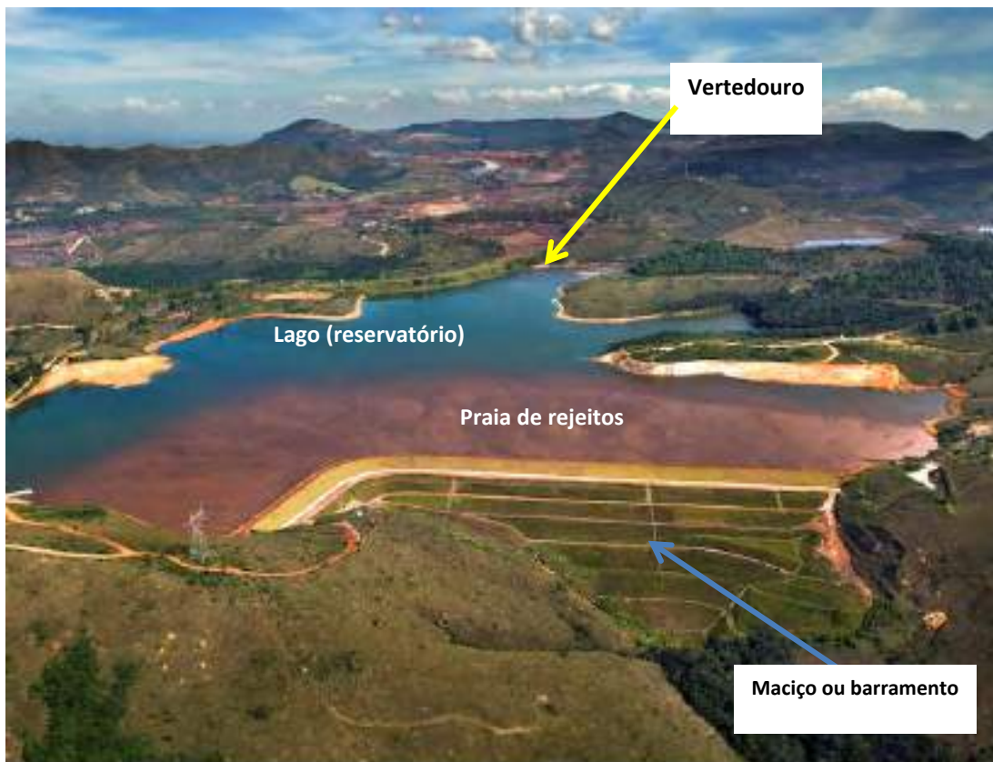
Figura 2.4.5.a Exemplo de barragem de rejeito
