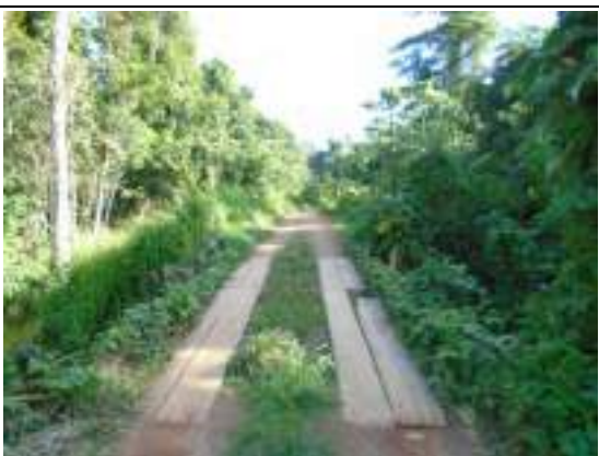
Foto 47: Ponte sobre o igarapé Mangueira – aldeia Lakariká (26/04/19).
