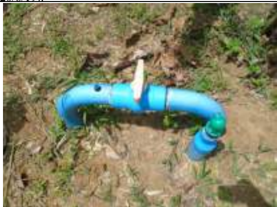
Foto 75: Registro do sistema de irrigação instalado na roça de Giliard (aldeia Miratu, 06/5/19).
