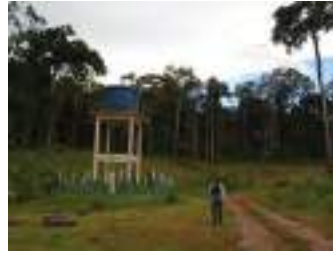
Caixa d'água Aldeia Furo Seco
