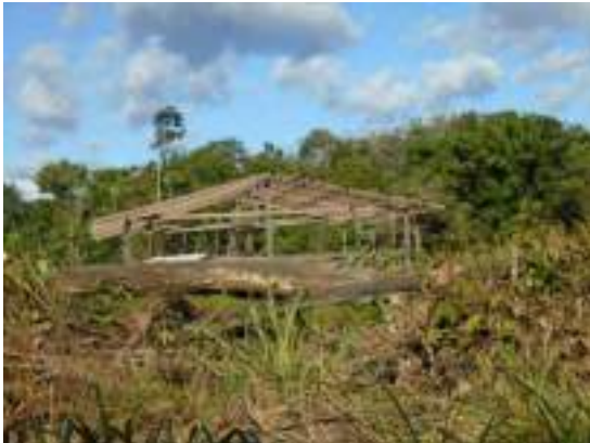
Foto 39: Residência em construção – aldeia Lakariká (26/04/19).
