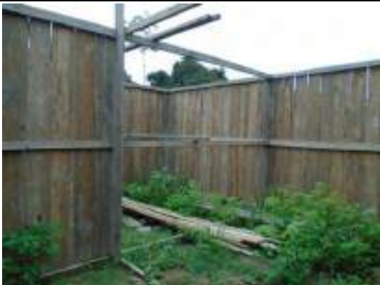
Foto 13: Casas em construção com tábuas de castanheira ( Bertholletia excelsa ), durante campanha de inverno na aldeia Lakariká (29/4/19).
