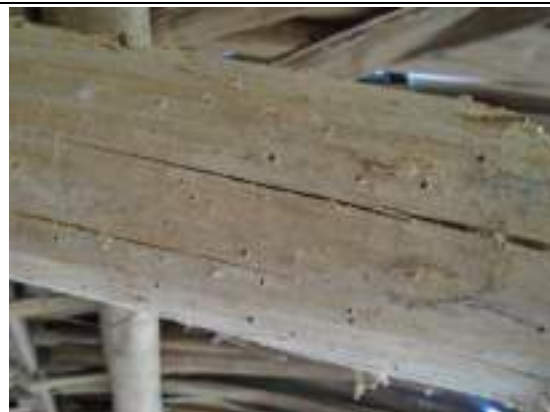
Foto 26: Madeira de ar utilizada em casa da aldeia Miratu com broca, por ter sido tirada na “lua ruim, lua nova” (08/5/19).
