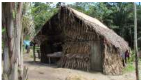
Foto 10: Detalhe de casa com estrutura de madeira e cobertura de palha de babaçu ( Attalea flexuosa ), na área do finado Toco (09/8/19).
