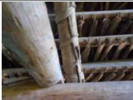
Foto 24: Amarra da casa de José Luiz Castelo Juruna Chipaia (Dedo Duro) feita com envira-preta ( Guatteria cryandra ) na aldeia Paquiçamba (03/5/19).
