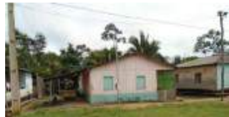
Moradia aldeia Paquiçamba com presença de postes de luz e fiação de eletricidade
