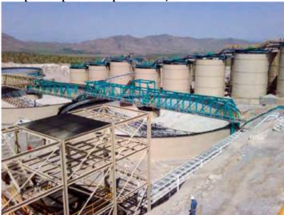
Figura 2.4.6.c Exemplo de sequencia Tanques de Lixiviação
