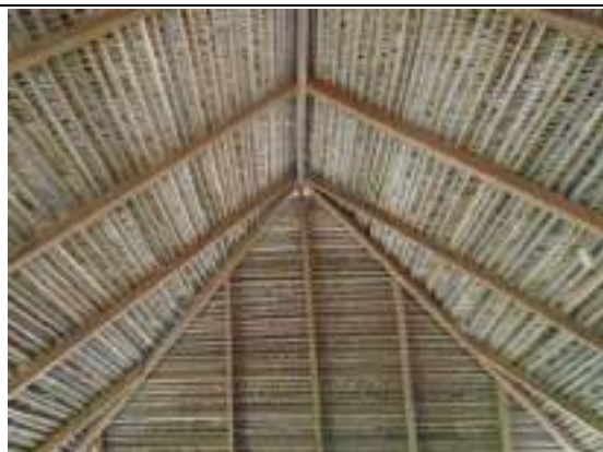
Foto 29: Detalhe da cobertura da Casa de Artesanato da aldeia Miratu (08/5/19), feita com palha de babaçu ( Attalea speciosa ).
