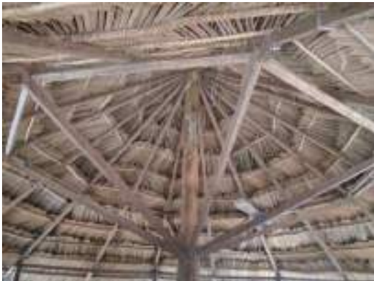
Foto 31: Cobertura da Casa de Reunião da aldeia Miratu (07/5/19) feita com esteio de acapu ( Vouacapoua americana ), madeira de cundururu ( Onychopetalum amazonicum ) e matá-matá ( Eschweilera sp.1) e cobertura de palha de injá ( Attalea maripa ).
