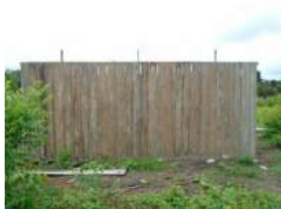
Foto 40: Residência em construção – aldeia Lakariká (26/04/19).
